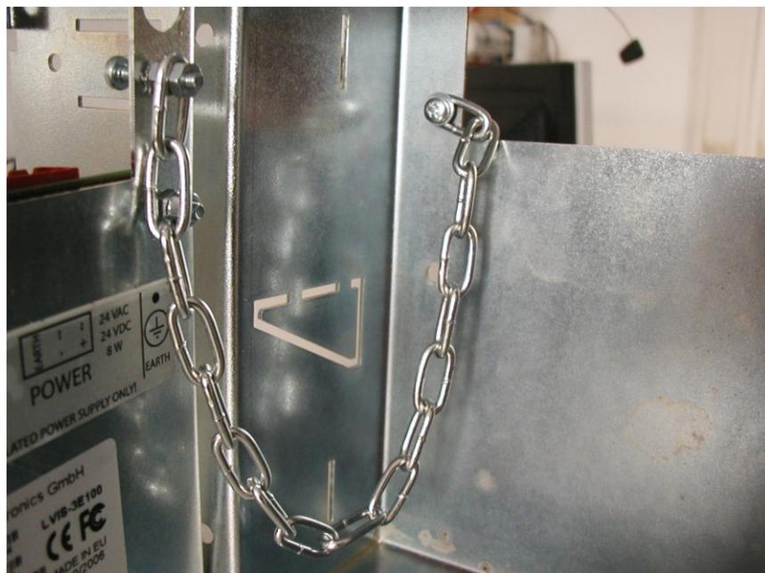
Abbildung 1: L-VIS Diebstahlsicherung
